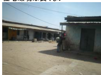
カノ都市部 扉や窓は壊れていたり、窓ガラスがはめられていないところが多数ある
