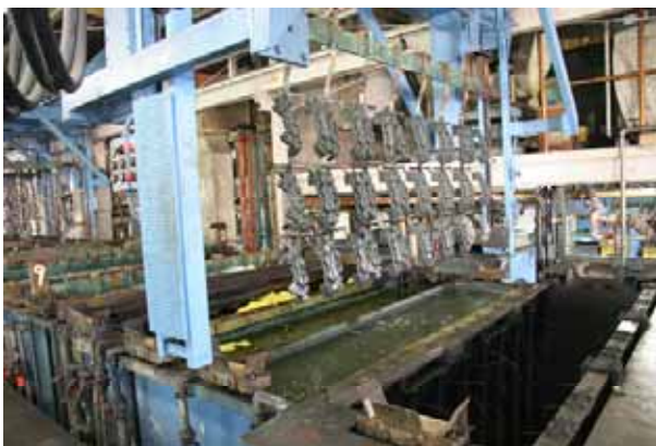
クロメート処理 (クロメート処理槽後)
