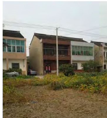
▲常州旭○車輛の倉庫写真
