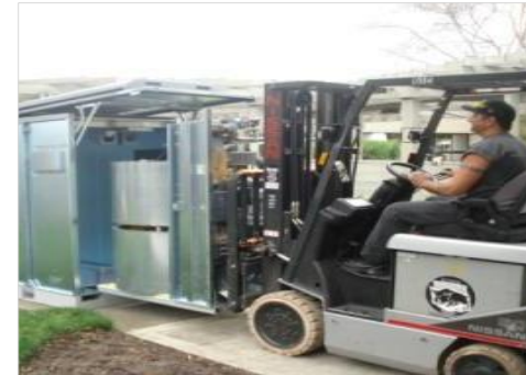
実例：発電モジュールの交換の様子
