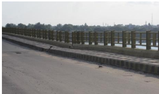
図 ES-6 センター・ヒンジ部のたわみ状況
