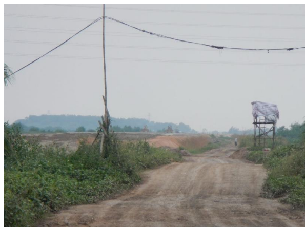
写-要 4 ハノイ-ハイフォン高速道路 施工状況
