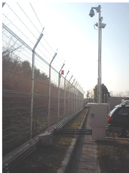
Photo 施工実施例 (出典：富士古河 E&C 株式会社)
