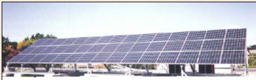
Generación de energía mediante celdas fotovoltaicas Tipo de cristal de silicón
