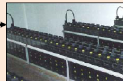
Baterías de almacenamiento La generación de electricidad puede suministrar una salida de energía estable al cargar y descargar las baterías
