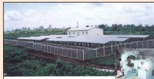
Este es un sistema híbrido auto-sustentado de generación de electricidad de 100kW PV, que incluye 1000kW PV y baterías de 689kWh, y generación de energía micro hidroeléctrica de 25kW usando un generador de inducción (proyecto NEDO)
