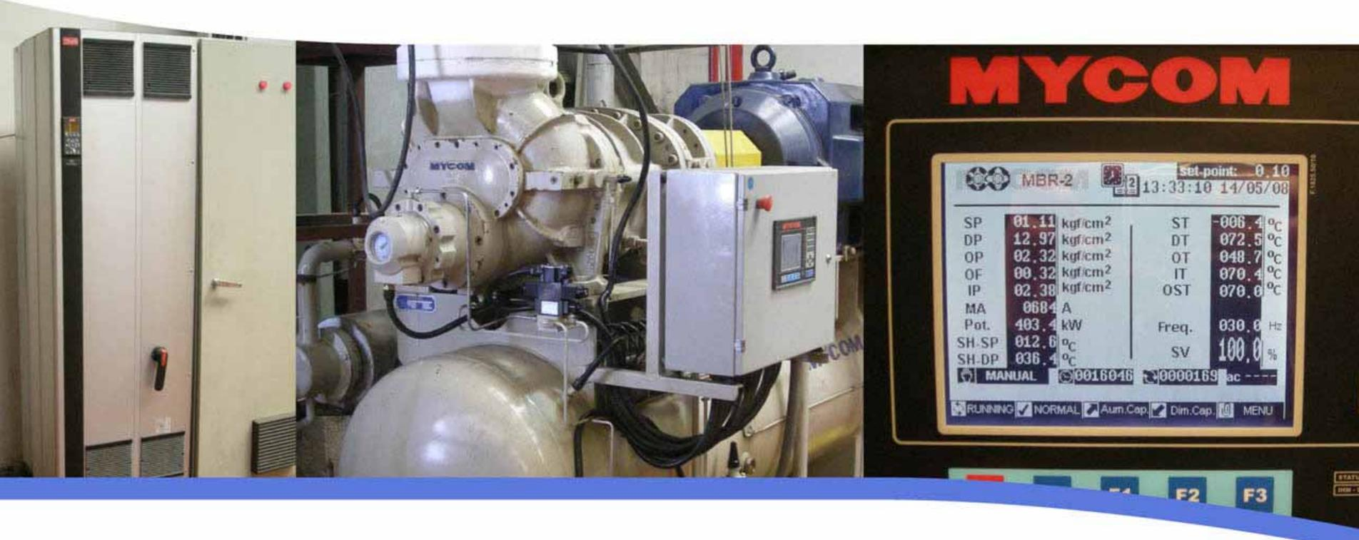
**Control de capacidad mediante variador de frecuencia**
