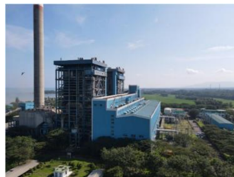
IHIがグリーンアンモニアの燃焼を検討するインドネシアPT PLN 社所有のLabuan石炭火力発電所 （出所）経済産業省資料
