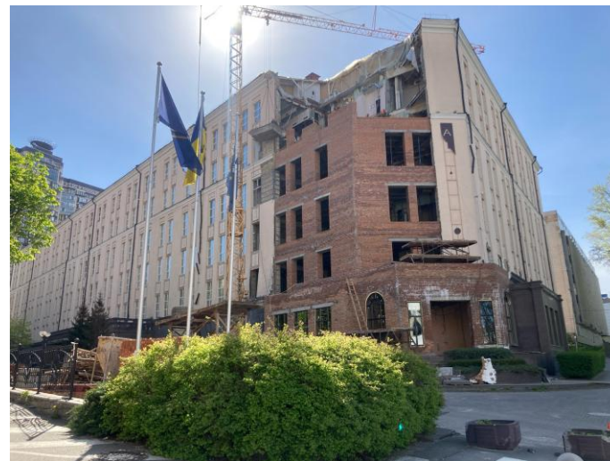
戦争の被害を受けた建物
