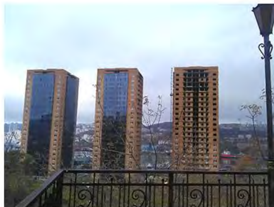
集合住宅の建設が進むウラジオストク（ジェトロ撮影）
