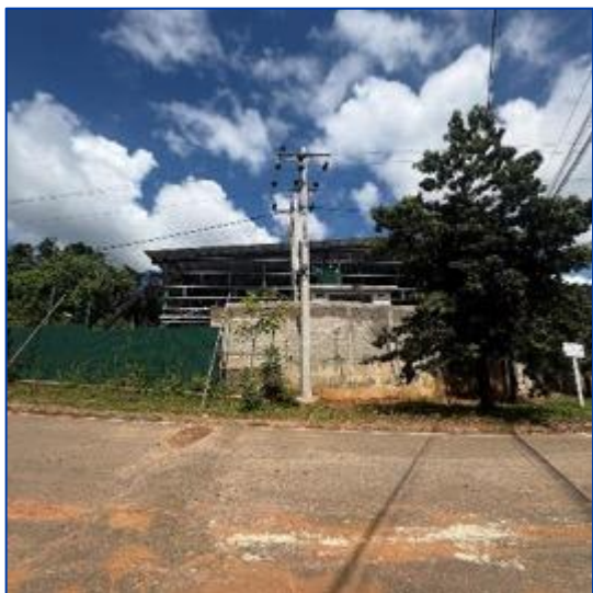
建設中の新工場
