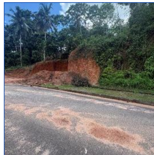
掘削作業実施中
