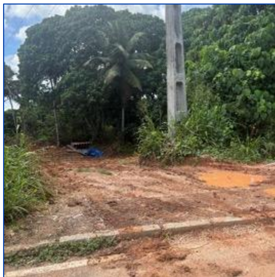
給水設備の改修
