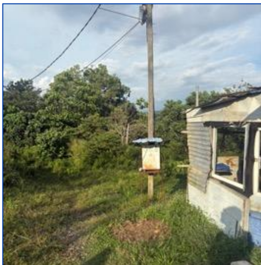
ユーティリティインフラは設置済み
