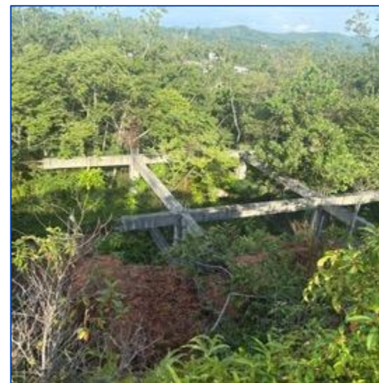
前回開発の設置構造物
