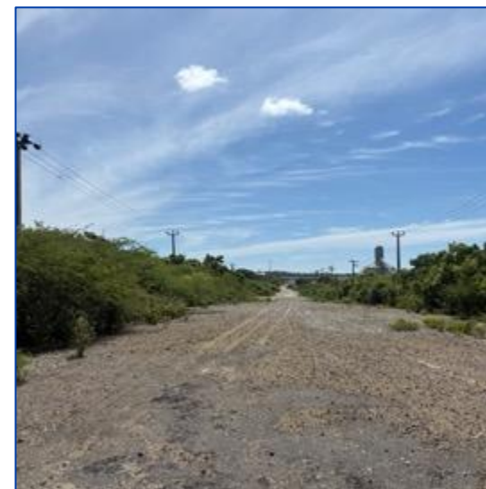
完成予定の内部道路
