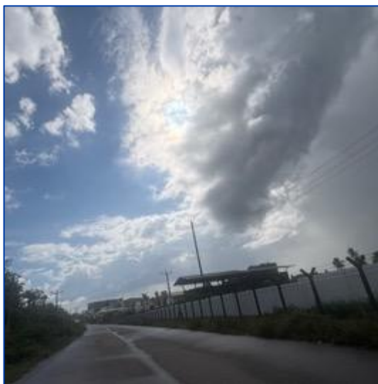
建設中の内部道路網
