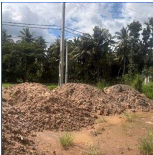
アクセス道路拡幅工事の進捗状況
