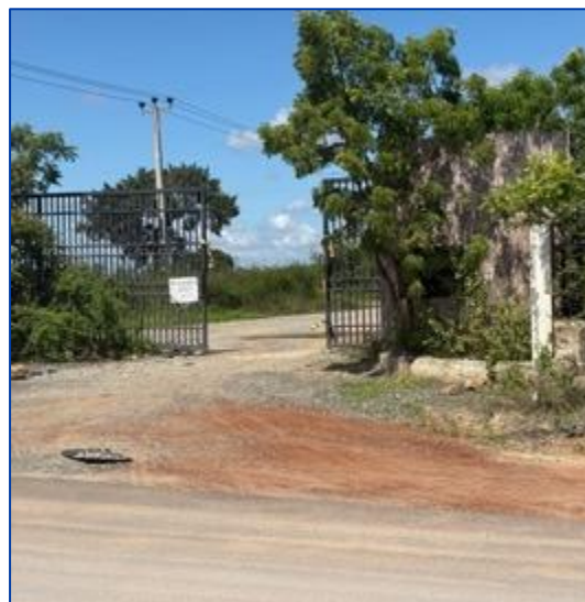
完成予定の内部道路
