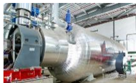
排熱回収発電
