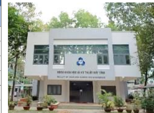
ホーチミン市第1キャンパス コンピュータサイエンス・工学部校舎 (調査員撮影)
