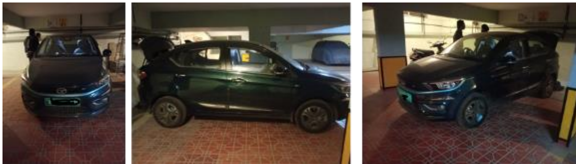
駐車場に充電設備を設置
