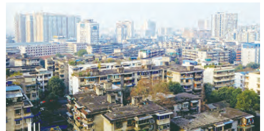
② 市の中心部には、築年数が長い古い低層マンションやアパートが多く残っている
