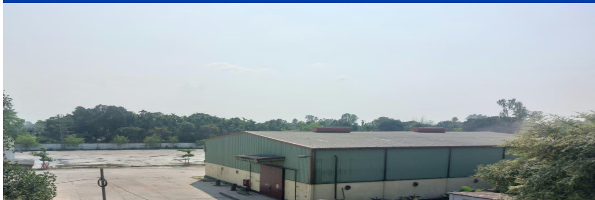
倉庫とトラックヤード
