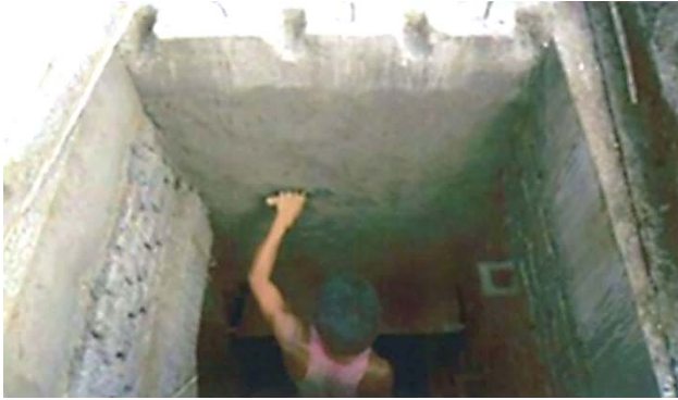
集水溝の改修工事 〔YCDC エンジニアリング局(水道供給・衛生部門)〕
