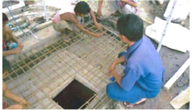
集水溝の改修工事 〔YCDC エンジニアリング局(水道供給・衛生部門)〕
