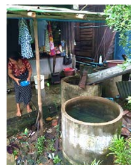
コンクリート土管の貯水槽
