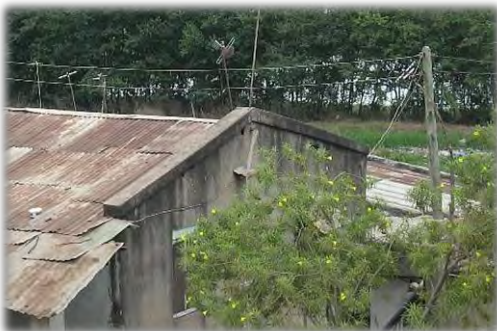
ダルエスサラーム 電柱とアンテナ
