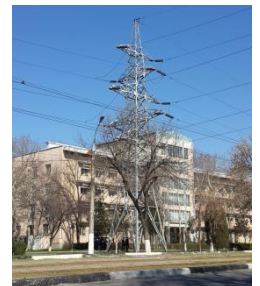
タシケント市内への高圧送電線
