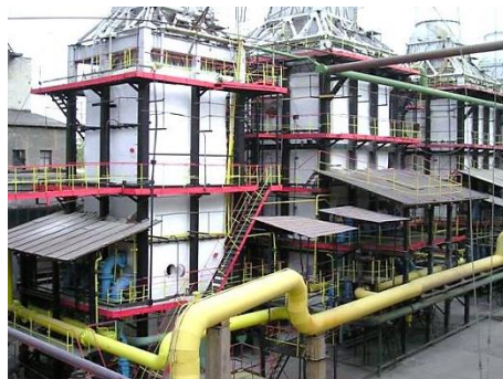
タシケント火力発電所
