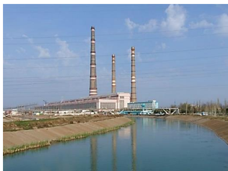
シルダリア火力発電所
