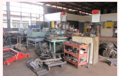
建設機械・機械学訓練校 内部
