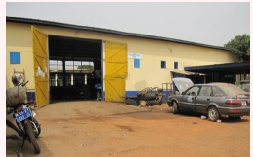
建設機械・機械学訓練校 概観
