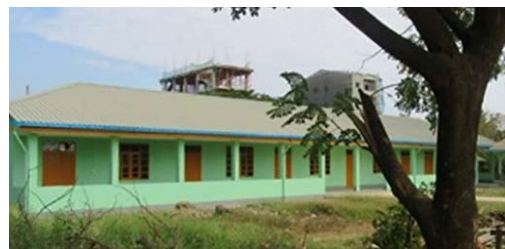
タケタ地区第14小学校の校舎
