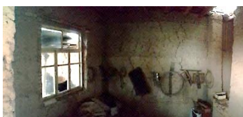
未完成の部屋
