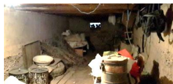
オープンテラスの下にある地下室
