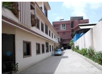
本社内化学研究室及び事務所棟
