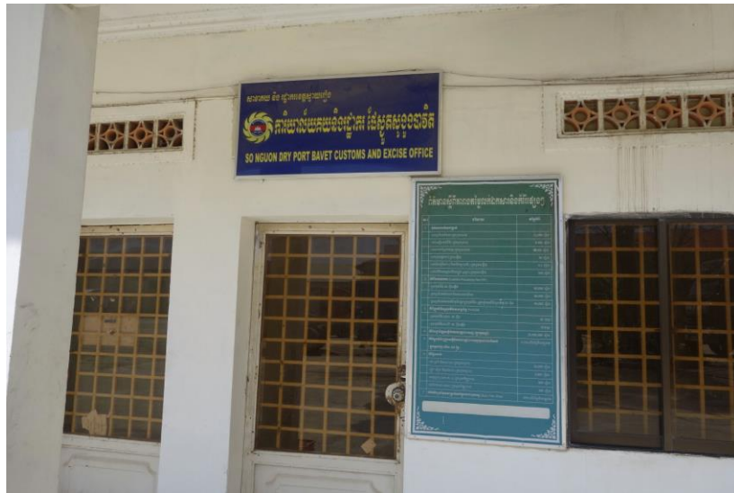
図 7-29 バベットのドライポート内にある税関事務所
