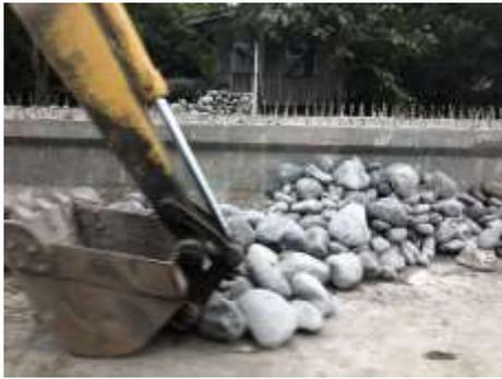
堤防の修復と流出した岩石の除去作業
