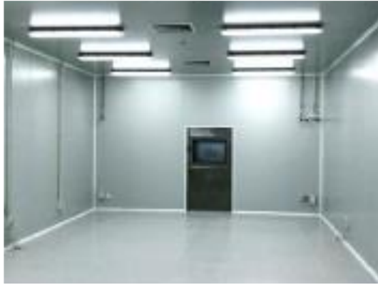
写真 6-2 据付前の培養室
