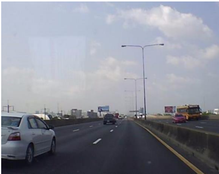
図 8.1.1-31 Don Muang Tollway の走行軌跡（一部）と車外の状況 （出典：Google, DigitalGlobe）
