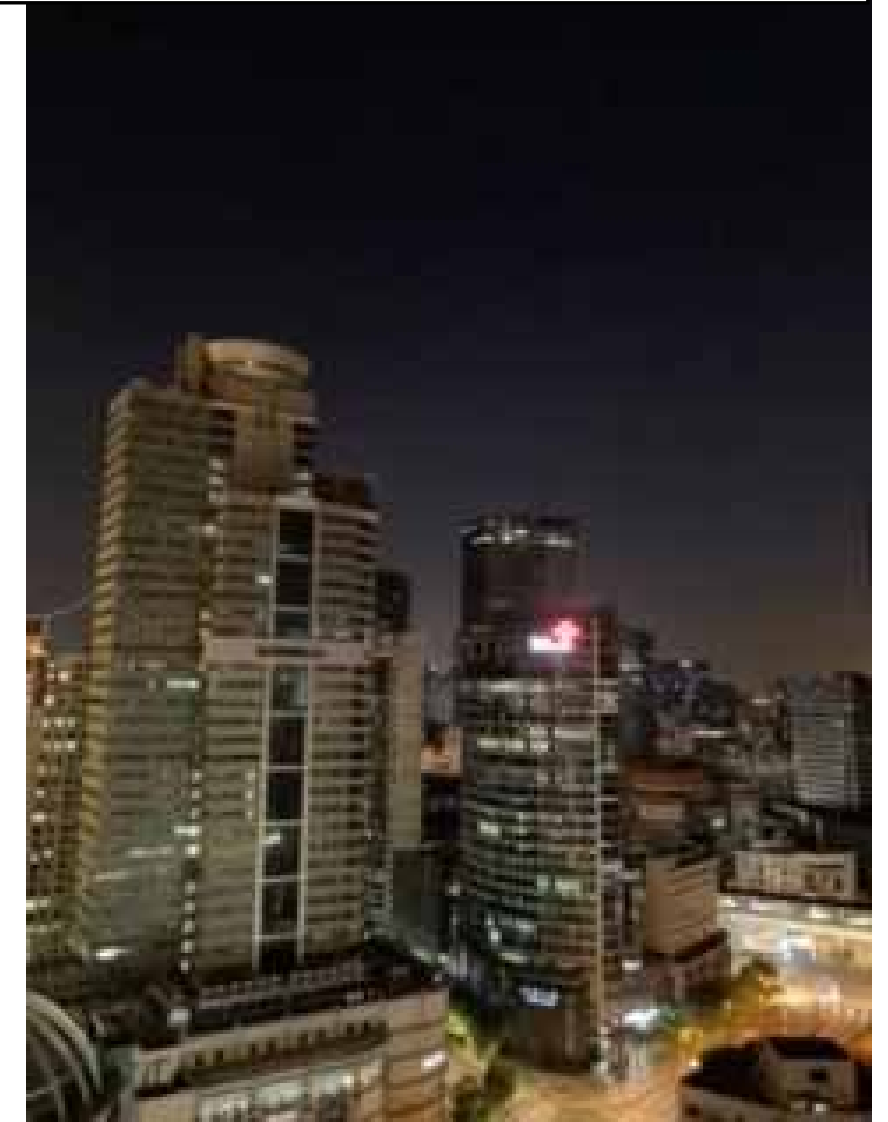
夕方既に真っ暗なオフィスビル。電気をつくフロアはおそらく職員が何週間も泊まり込み
